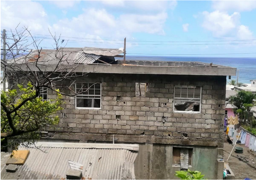
Beschädigtes Wohnhaus in New Sandy Bay durch herausgeschleuderte Steine beim Vulkanausbruch
