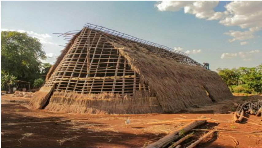
Eindeckung des Daches mit Sapê-Gras
